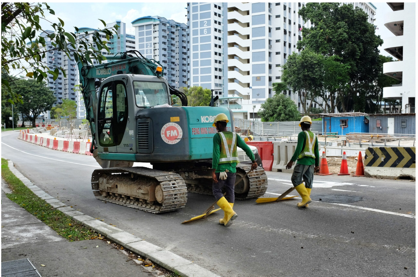
Migrantische Arbeitskräfte auf einer Baustelle in Singapur © Jnzi`s, flickr, CC BY 2.0
