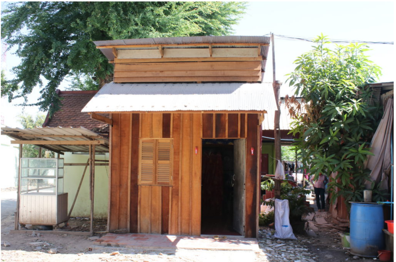
Ein neugebautes Haus, das auf die Ideen des Climate Smart Design zurückgreift. Sichtbar ist, dass die Lüftung unter dem Dach, Fenster und Dachüberhang berücksichtigt wurden © STT
