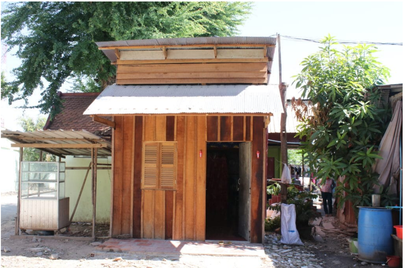
Ein neugebautes Haus, das auf die Ideen des Climate Smart Design zurückgreift. Sichtbar ist, dass die Lüftung unter dem Dach, Fenster und Dachüberhang berücksichtigt wurden © STT
