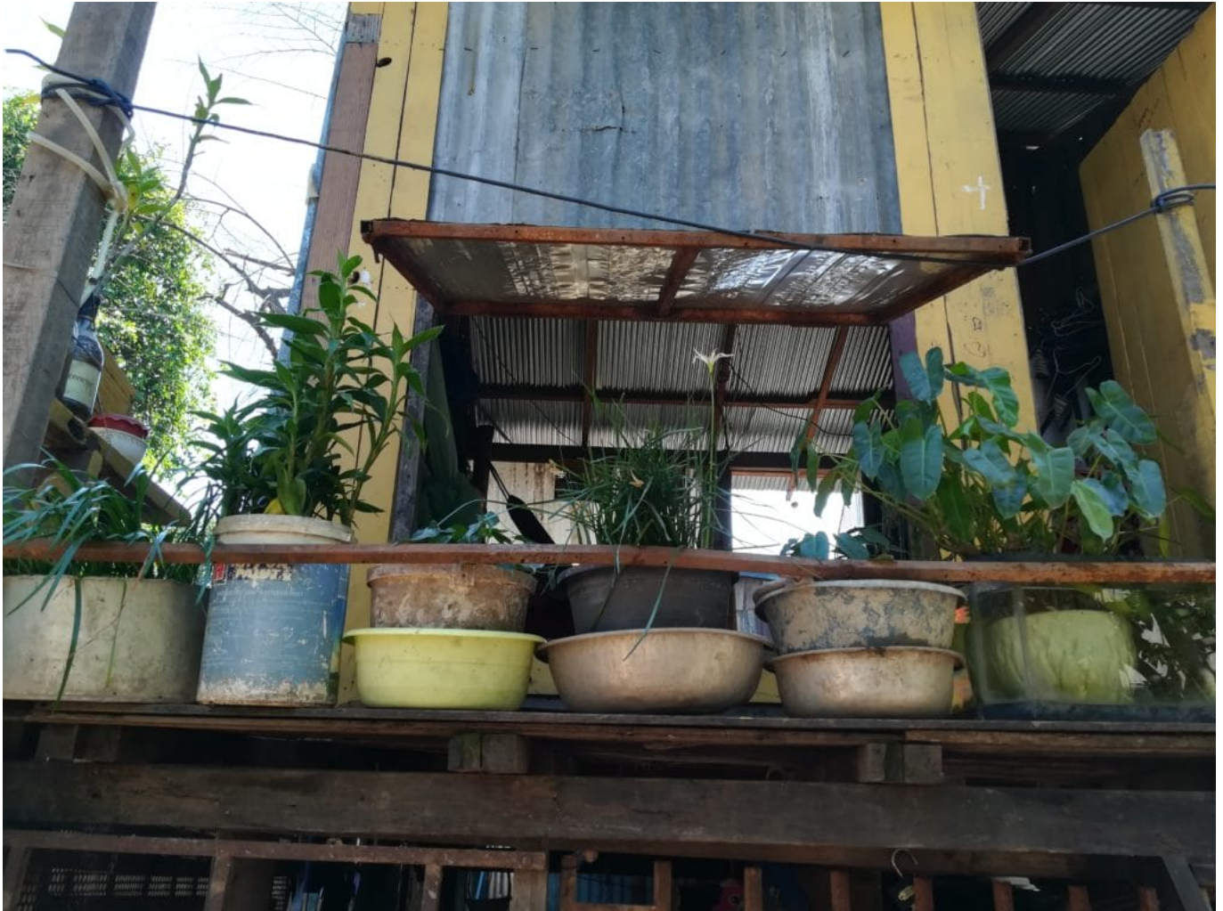
Ergänzte Isolierung und Pflanzen; vor allem größere werfen Schatten auf Fenster, Bäume halten Sonnenlicht von den Häusern ab © Raphael Goepel
