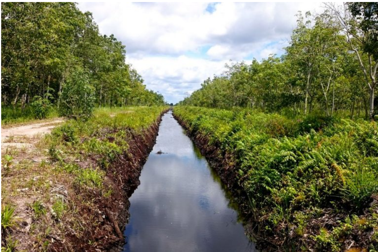
Ein Kanal des Mega-Reisprojekts bei Palangkaraya © Indra Nugraha/Mongabay Indonesien
