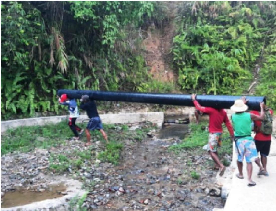
Bewohner\*innen von Katablangan, Philippinen, errichten in Eigeninitiative ein Kleinwasserkraftwerk. Mit dem Rohr stellen sie die Verbindung zwischen einem Damm und dem Generator her. © J. Erasquin - SIBAT
