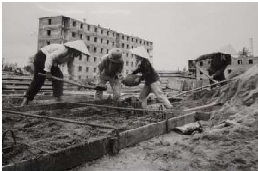
Bau der Wohnanlage von Quang Trung in den 1970er Jahren. © Gerd Gottschalk, alle Rechte vorbehalten
